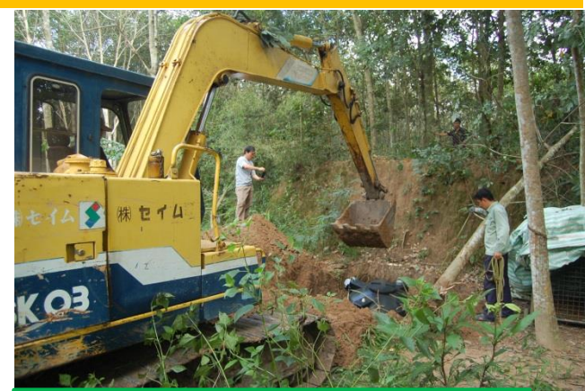
Hình 5: Bồn được đặt trong hố đào sẵn đảm bảo cân bằng mặt đáy và đúng kỹ thuật
