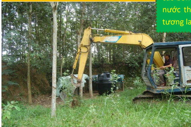
Hình 3: Máy xúc đang đào hố để chôn bồn tự hoại
