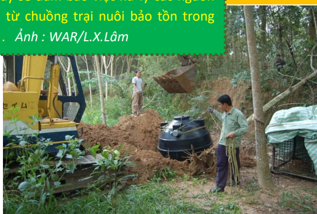
Hình 4: Máy xúc đang đưa bồn xuống hố
