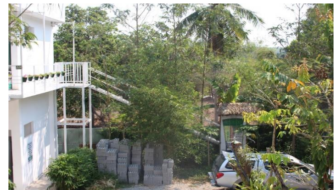
Cầu thang thoát hiểm tại Khu nhà hành chính của Trạm
